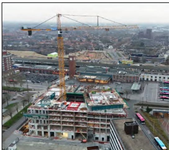
Nieuwe Metterswane in aanbouw
