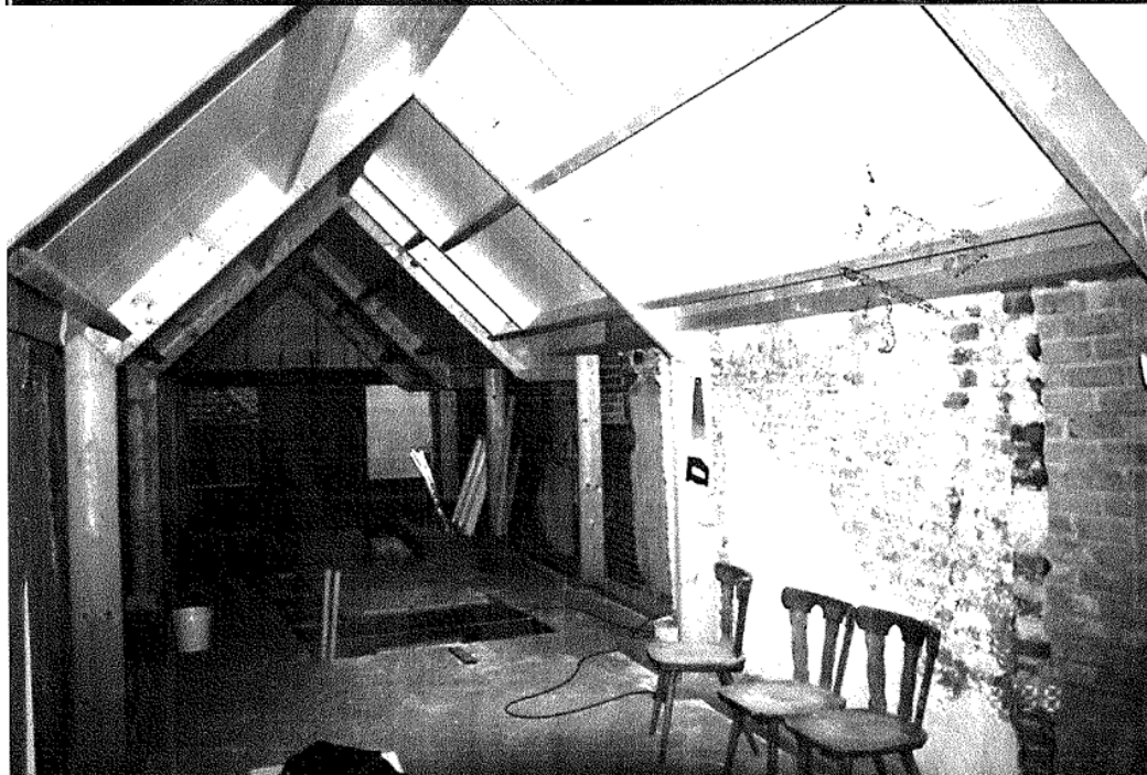
Foto's van de nieuwe kapconstructie zoals deze in 1998 is geplaatst met daarop ook delen van de historische zijmuren. Bron: Digitaal Bouwarchief Nijmegen.
