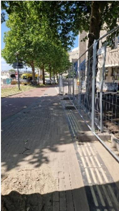
Figuur 22 Werkzaamheden belemmeren geleideroute (eigen afbeelding)
