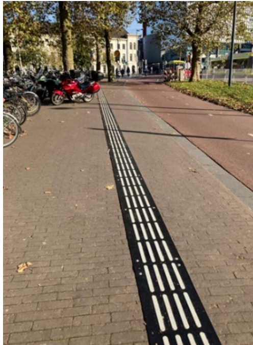
Figuur 23 Tijdelijke geleideroute (TGlining)
