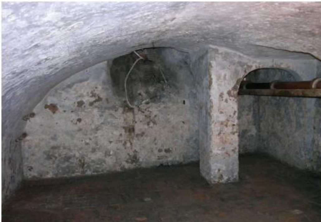
Zicht in de kelder richting voorgevel met rechts het restant van het trapportaal waarin de trap naar de straat was ondergebracht. Foto: F. Haans MAB 2007, uit: F.A.C. Haans, Kelder van het voormalige huis van de familie Maelwael/gebroeders van Limburg, Burchtstraat 63-65 in Nijmegen, 18 november 2015.
