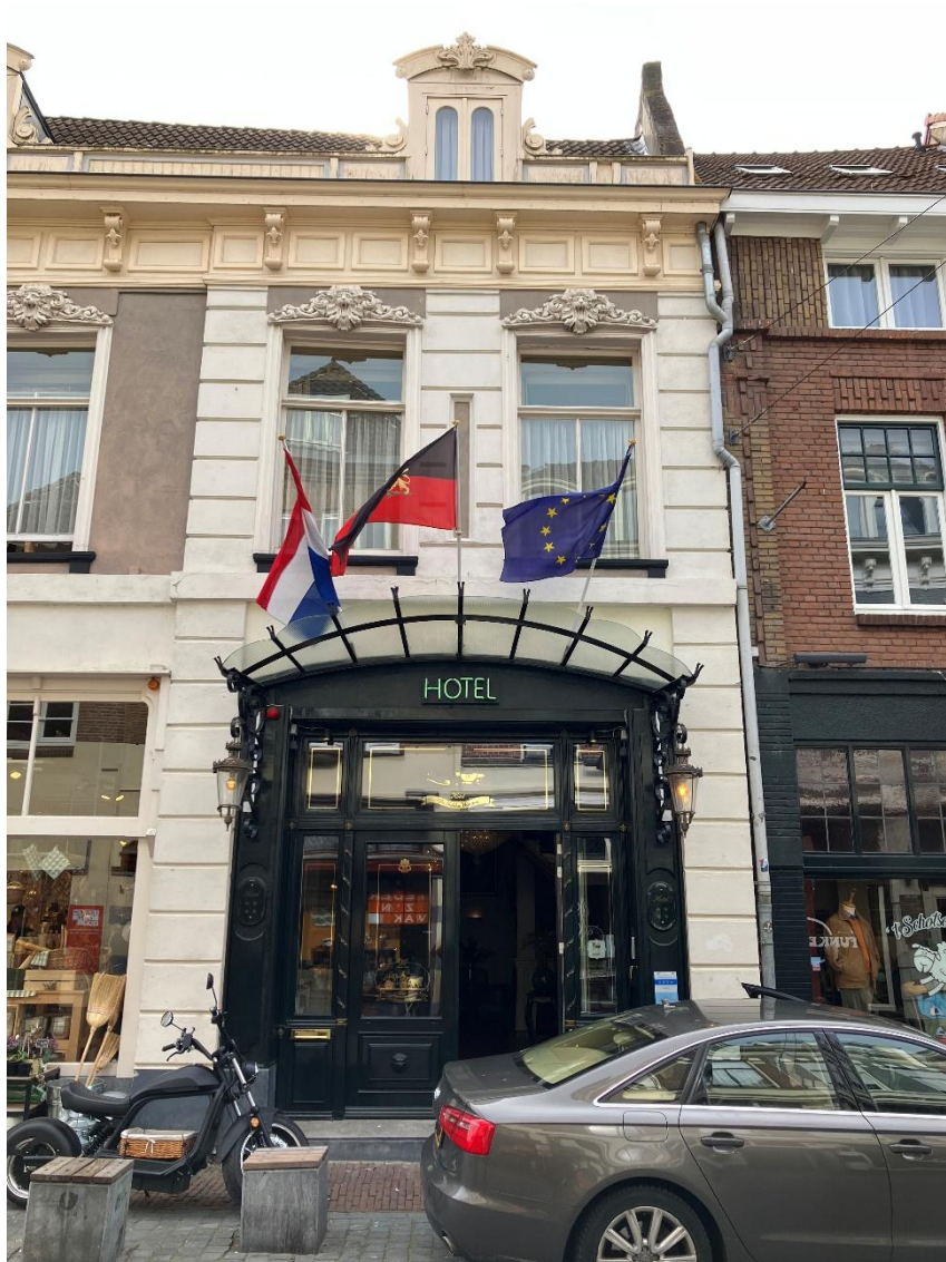
Voorgevel Lange Hezelstraat 75a
