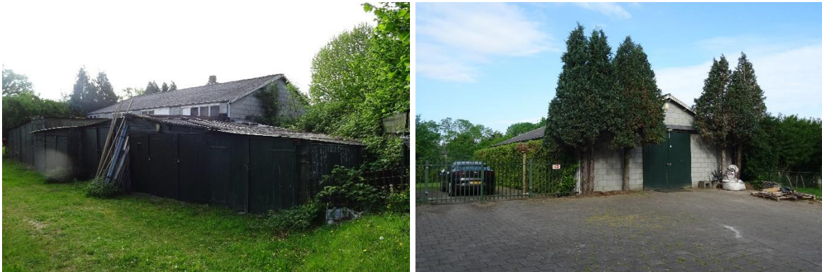
Afbeelding 3 en 4: De te slopen bebouwing. Bron: BNL advies. Datum: 11-05-2022
