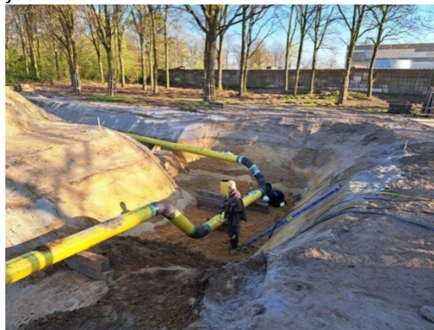
Figuur 8 Verlegging gasleiding Kanaalknoop Zuid
