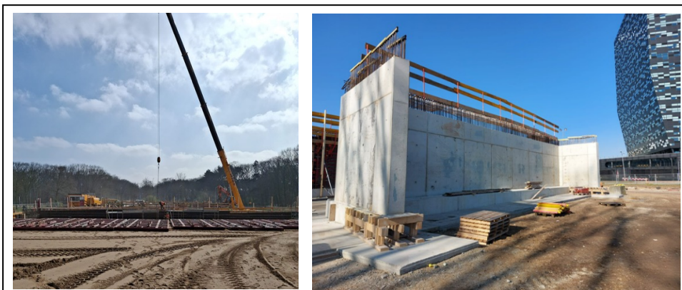
Figuur 4 Werkzaamheden aan onderdoorgangen Jonkerbosplein
