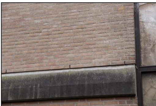
Foto 3 Spouwmuur in schoolgebouw
