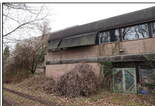
Foto 2 Westzijde van schoolgebouw
