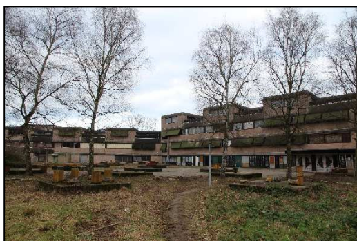
Foto 1 Voorzijde schoolgebouw richting noordwest gezien
