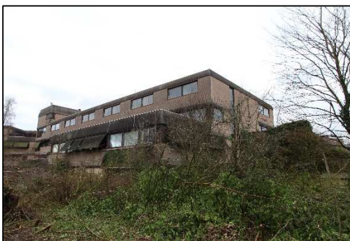
Foto 4 Noordzijde van schoolgebouw
