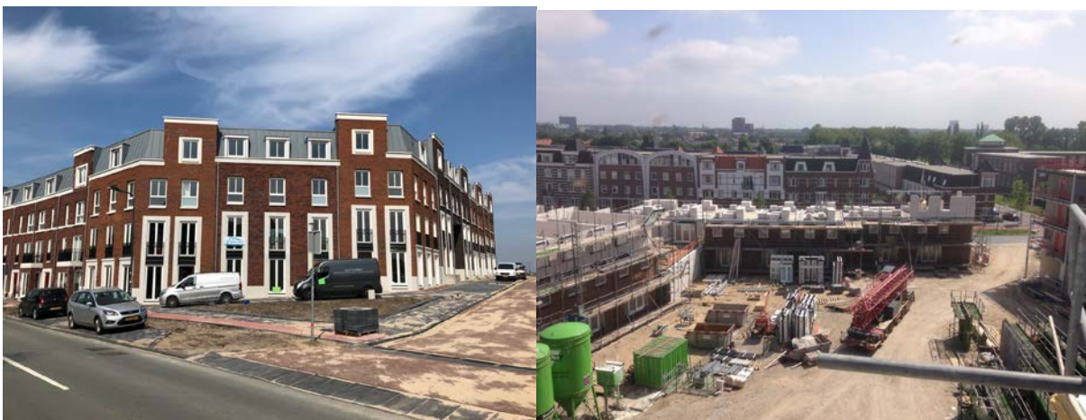
-Werk in uitvoering blokken 3 en 4
