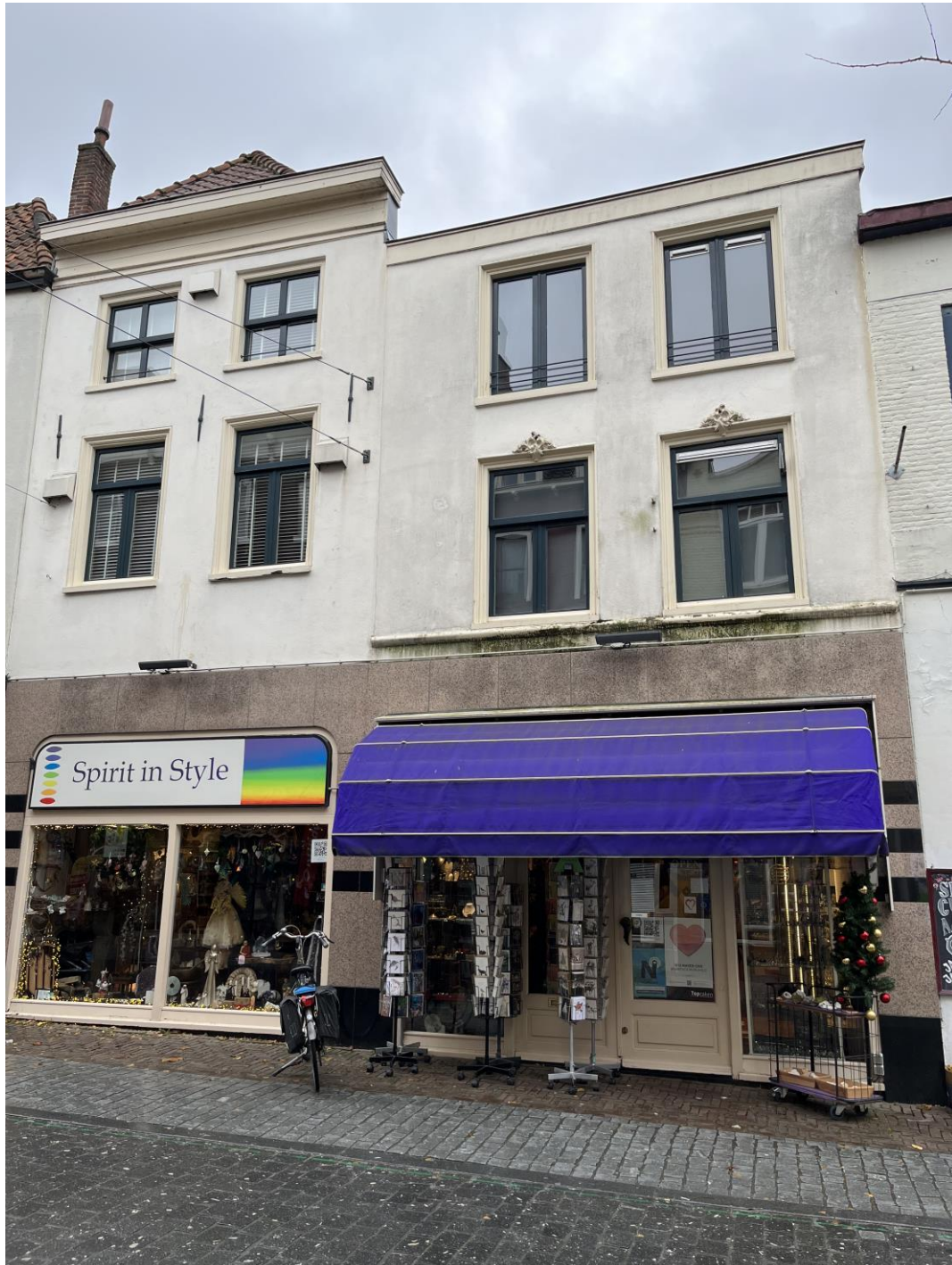
De voorgevel (rechts)
