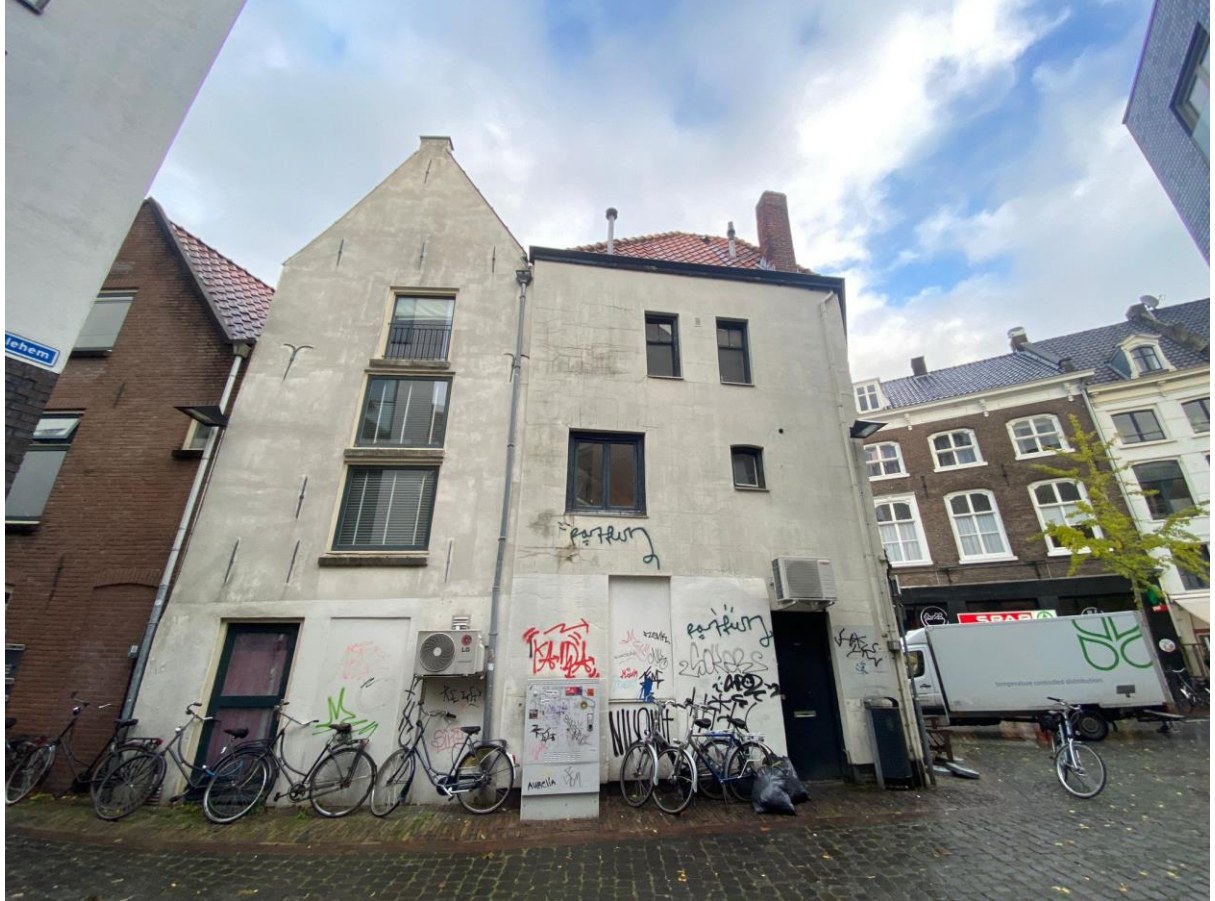
De gepleisterde gevel van Hessenberg 35a. De invullingen zijn recent geplaatst. De muurankers geven de hoogte van de verdiepingvloeren aan.
