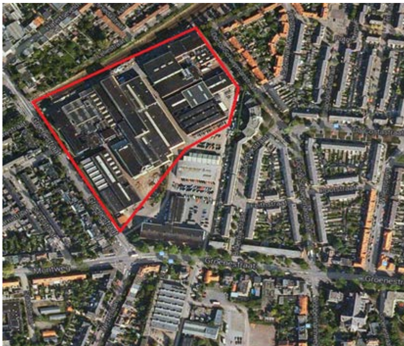
Foto: situatie ter plaatse van Royal Smit Transformatoren B.V.
