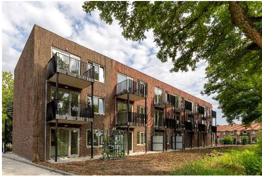
Foto: ECO architecten, Huissen
