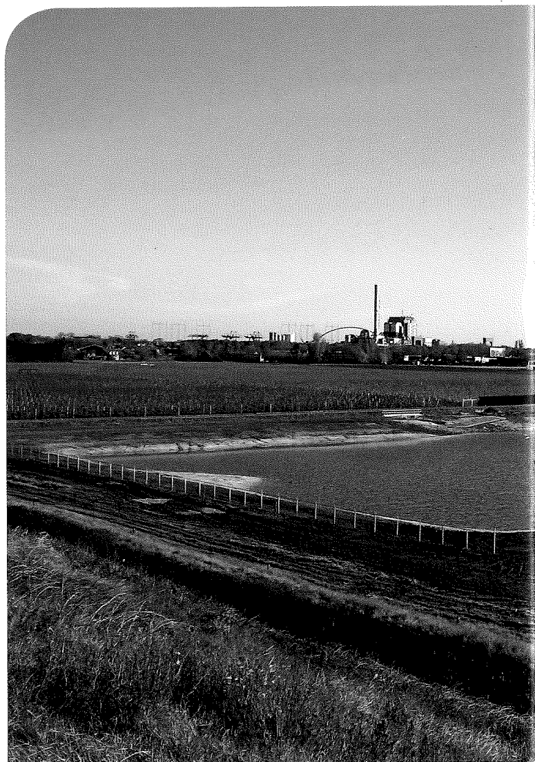
Waterberging in aanleg.
