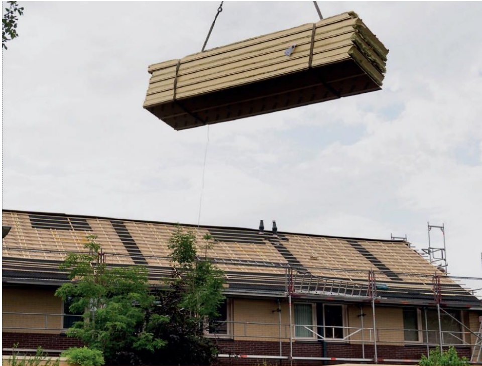
Aanbrengen dakisolatie
