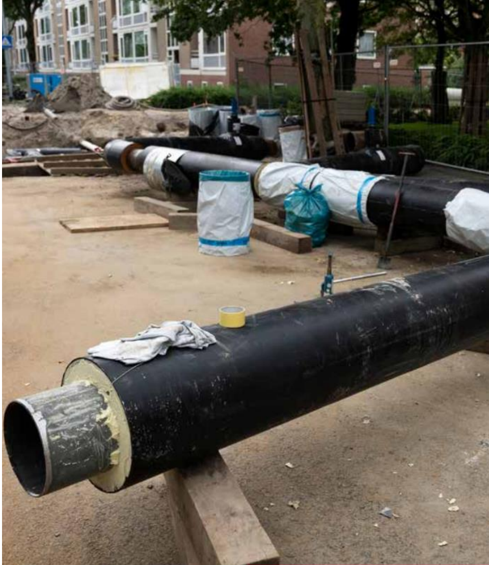
Een warmtenet in aanleg
