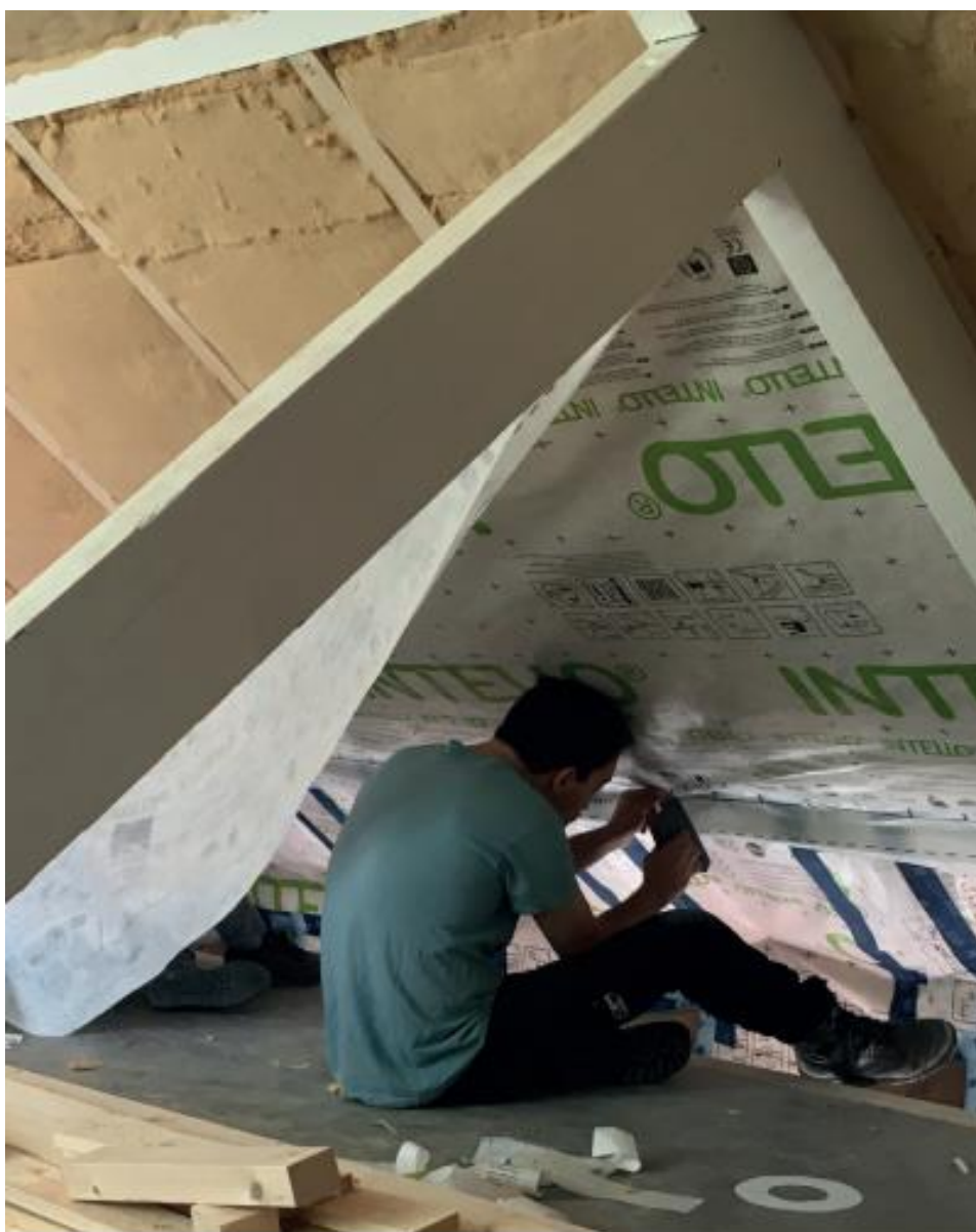
Aanbrengen kapisolatie
