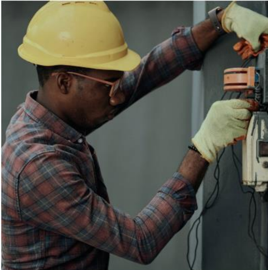
Aanpassingen van elektra in de woning
