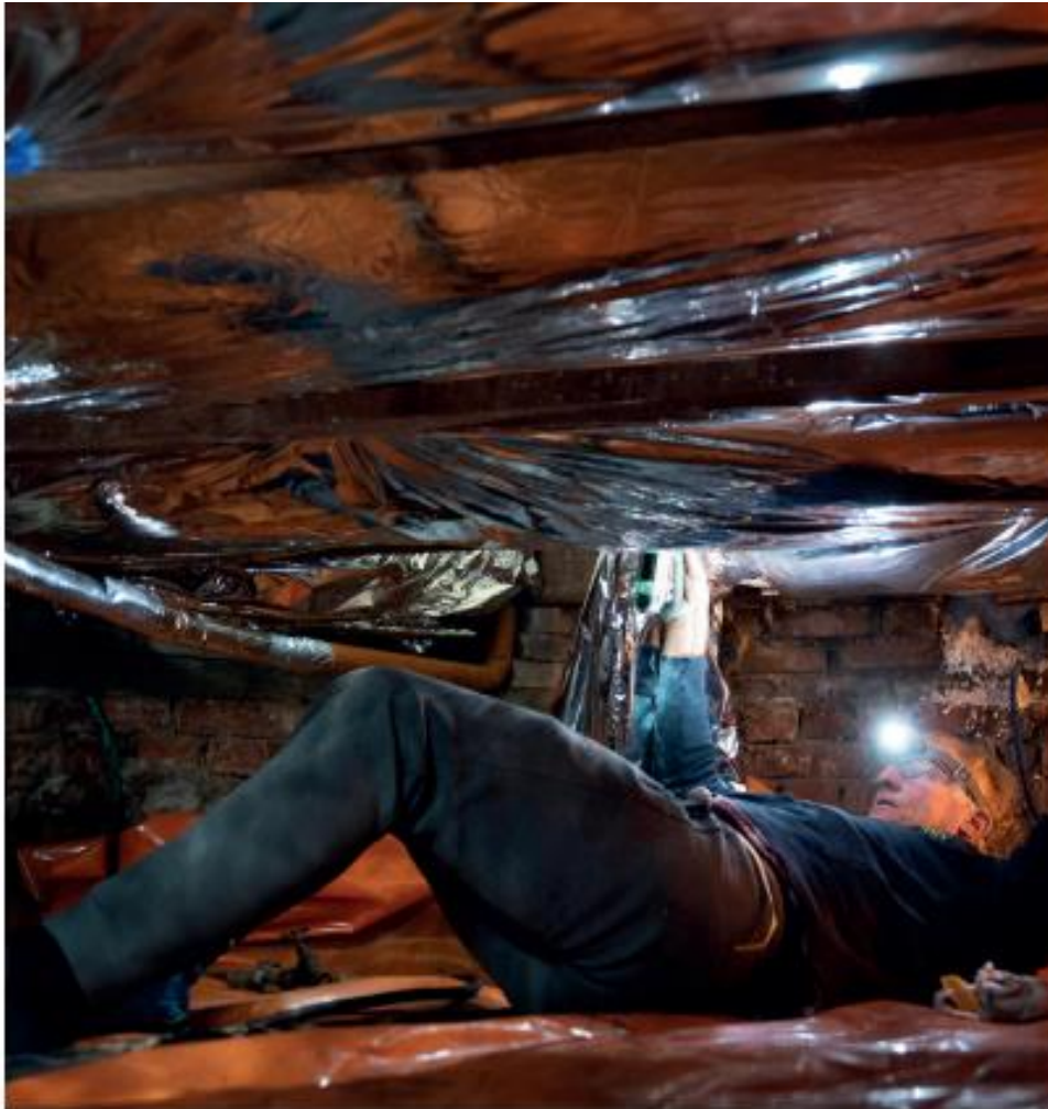
Het aanbrengen van vloerisolatie
