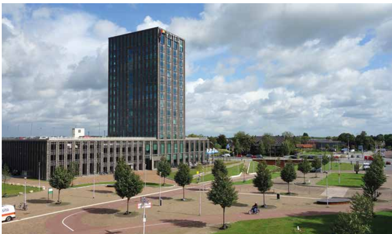
Nieuwbouw hotel Van der Valk.
