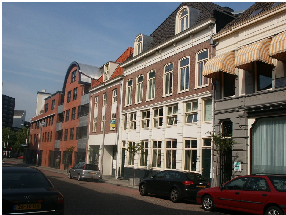
nieuwbouw en renovatie van Berchenstraat
