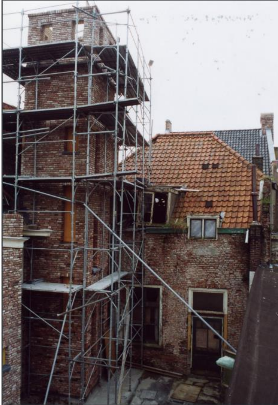
Achtergevel met lifttoren in aanbouw in 2002 (Bron: bouwhistorische verkenning).
