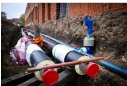
Figuur 4.05 Warmteleiding in aanleg
