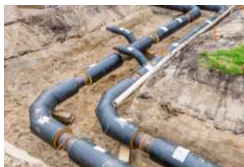
Figuur 4.06 Warmteleiding met aansluitleidingen
