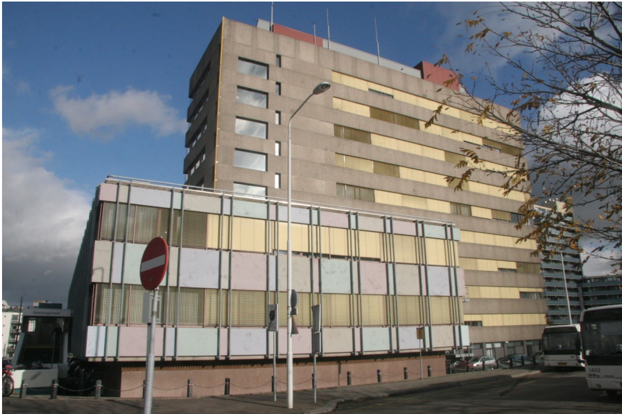
Figuur 4: Aanzicht gebouw vanaf Stationsplein
