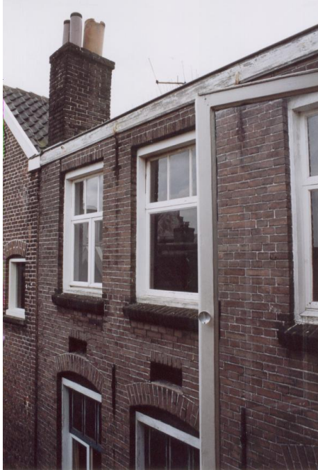
Zicht op de achterzijde van het pand, vanuit het tussenlid. Bouwhistorisch rapport (2002).
